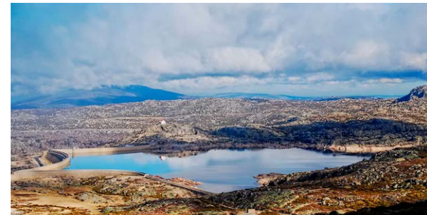
Barragem Lagoa Comprida
